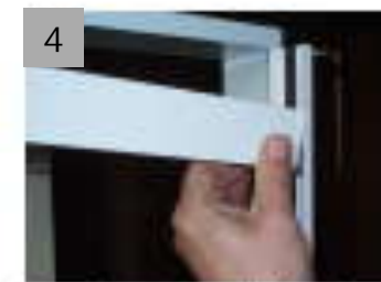
4 Inserire l'altra estremità della guida nel profilo di battuta e fissarla nel vano.
