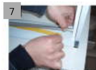
7 Asportare la pellicola del bi-adesivo ed incollarla al pavimento.
