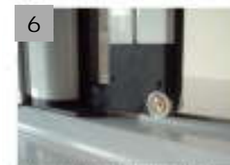
6 Infilare la guida inferiore sotto la carrucola e posizionarla davanti alla prima maglia della catena in modo da tenerla bloccata
